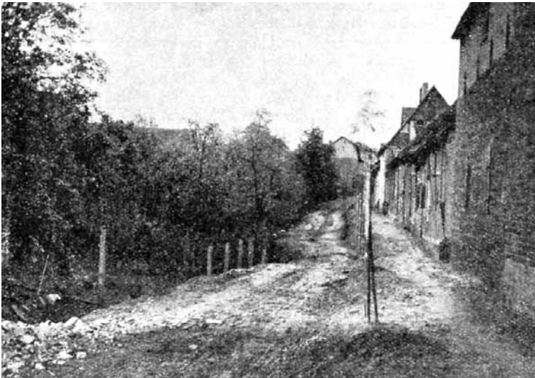
Bild 8 Die heutige Barbarossastraße war bis 1929 ein tiefer Flutgraben. Ebenso wie an der Südflanke (Mainstraße) nutzte man bei der Anlage des Städtchens Neuental den sich zweigenden Hohenberg-Graben zur Ortsbefestigung. Gebäuderiegel, wie rechts noch erkennbar, ersetzen eine teure Stadtmauer.
